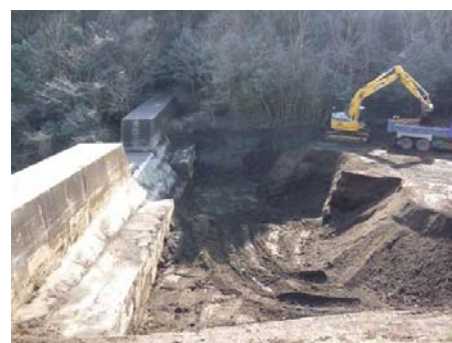
霧島山(新燃岳)の噴火時に行われた緊急除石
