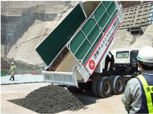
【コンクリート初打設 平成22年5月21日】
