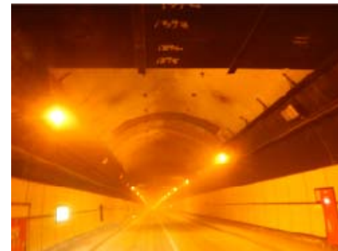
天井板撤去後の状況
