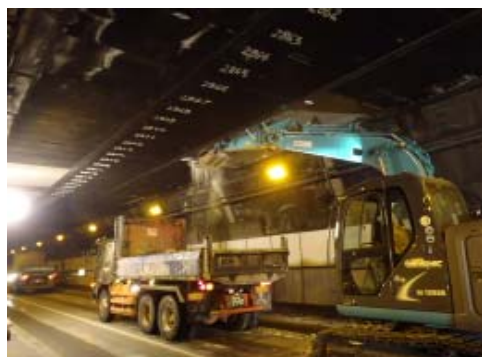
天井板撤去状況
