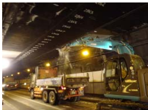
天井板撤去状況
