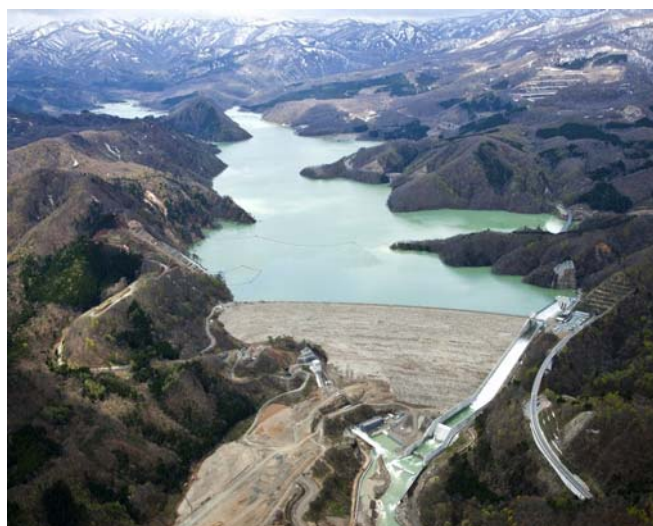
胆沢ダム全景（平成 25 年 5 月撮影）
