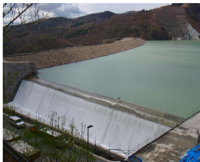
最高水位に達した胆沢ダム（平成 25 年 5 月撮影）
