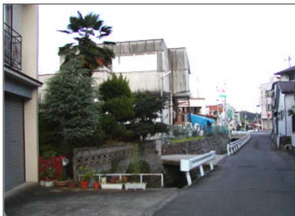
六角川 市街地部 現況
