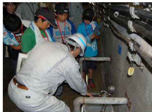
(監査廊での漏水量調査)
