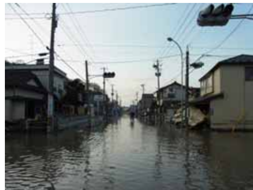
大潮時での浸水状況 (H23.4.21撮影 石巻市湊町付近)
