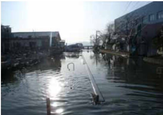
大潮時での浸水状況 (H23.4.21撮影 石巻市門脇町付近)
