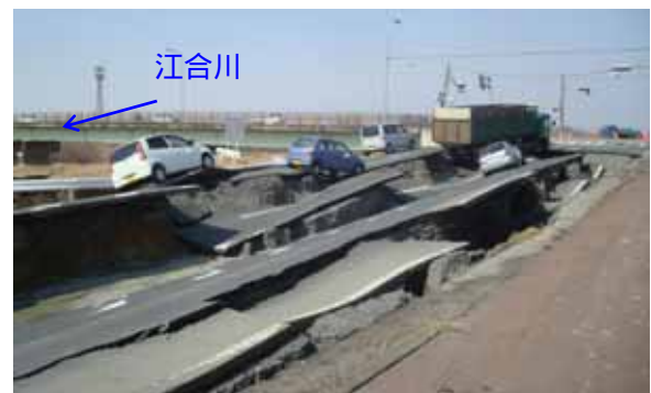
地震による堤防崩壊 (江合川右岸27.6k付近 大崎市古川瀧尻地先)
