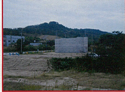
④ 桂根二線橋 A2橋台
