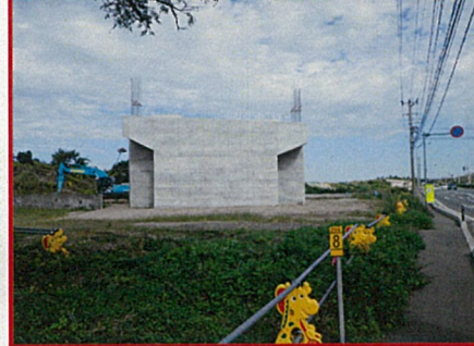
③ 桂根二線橋 A2橋台
