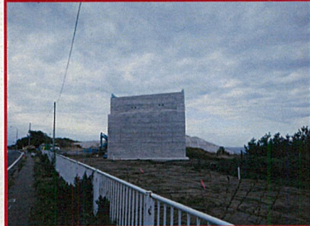
② 羽川二線橋 A1橋台
