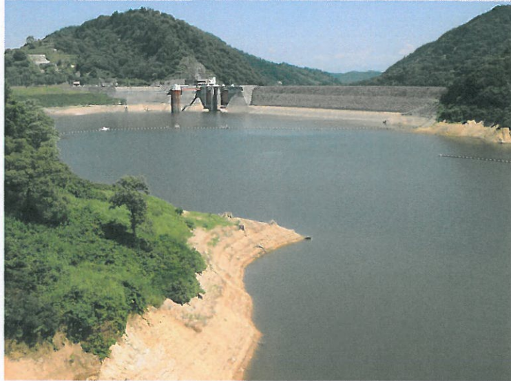
白川ダム貯水池状況写真（平成24年8月21日現在）
