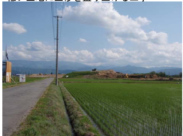
低い土地に土砂を盛り上げる工事
