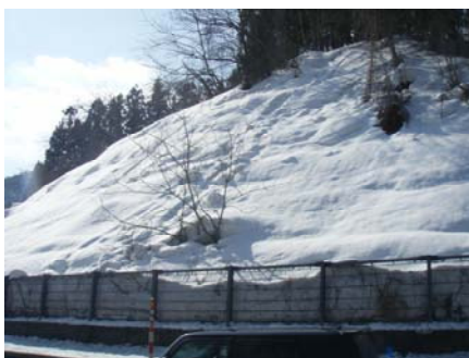
▲雪崩点検箇所
