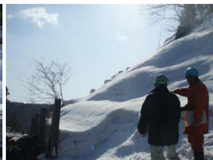
▲雪崩点検実施状況
