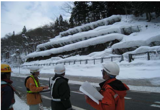
【雪崩点検実施状況】
