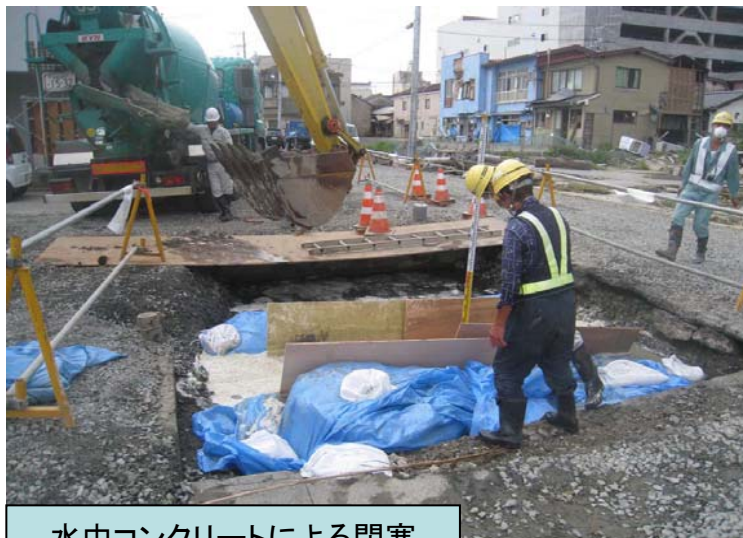
水中コンクリートによる閉塞
