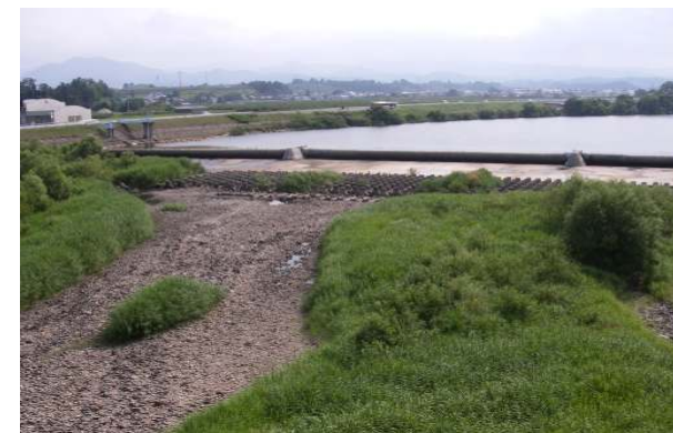
8/9取水堰状況写真
