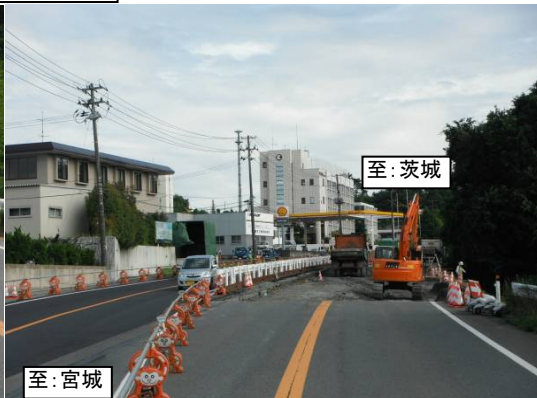
▲復旧工事状況
