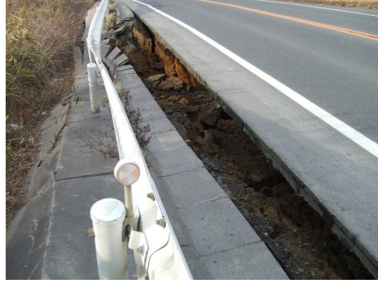
▲震災により盛土法面崩落
