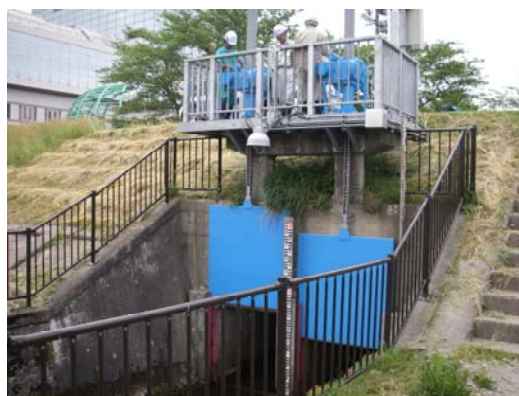
【施設点検の様子】
