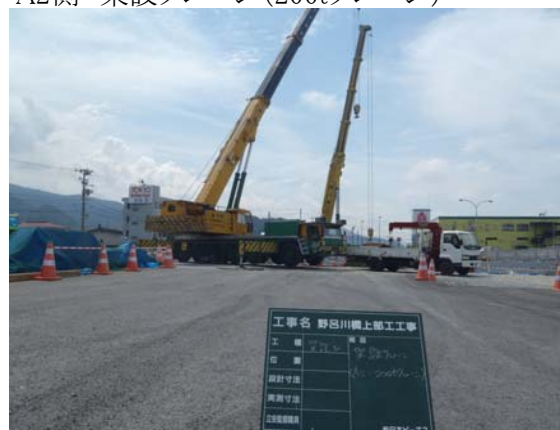
A2側 架設クレーン(200tクレーン)
