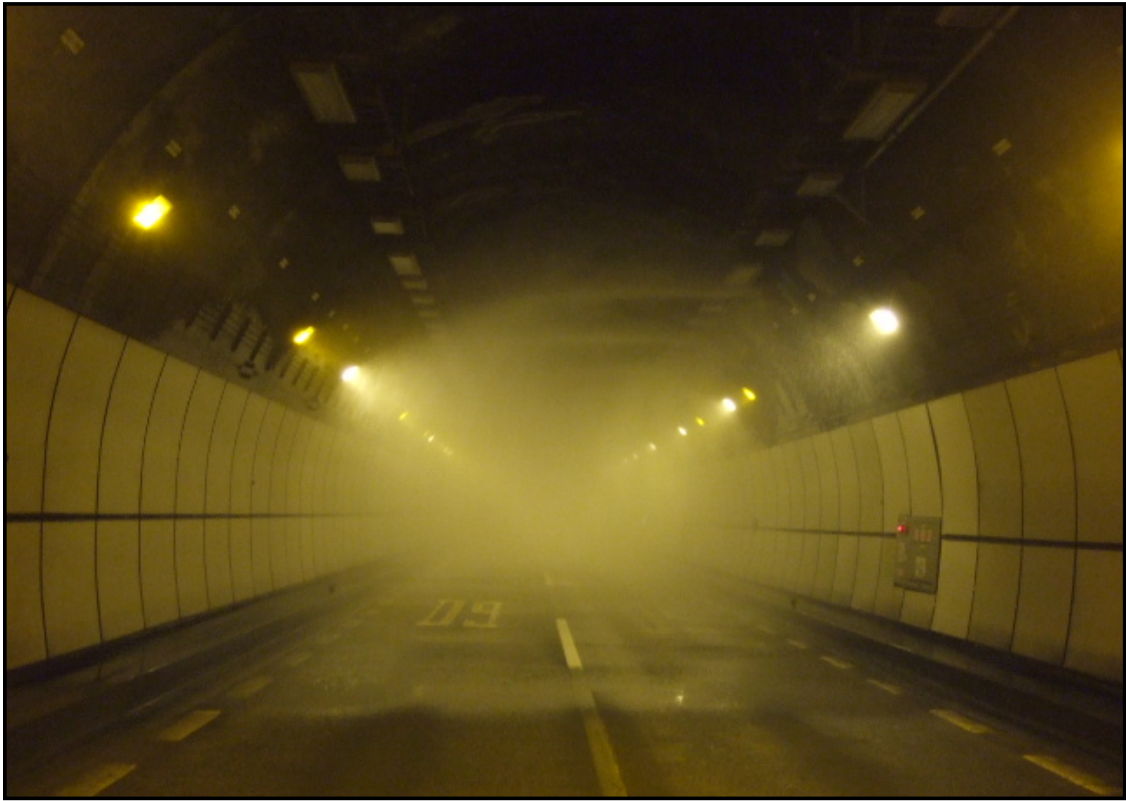
スプリンクラー水噴霧状況
