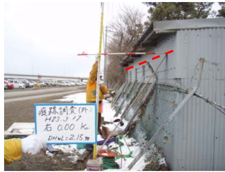
【右岸・川側】 河口部(0.0km)付近
