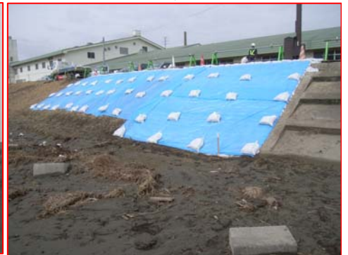
15日 10時05分 応急復旧完了 (土のう積み+シート張)
