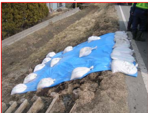
14日 13時30分 応急復旧完了 (土のう積み+シート張)
