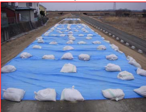
13日 16時00分 応急復旧完了 (シート張)
