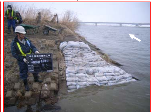
17日 14時53分 応急復旧完了 (クラック部に土のう充填)
