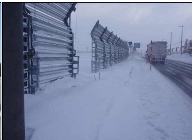
地吹雪発生時における防雪柵の状況
