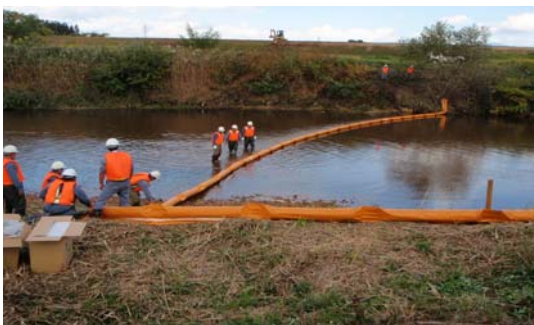
オイルフェンス横断工法訓練
