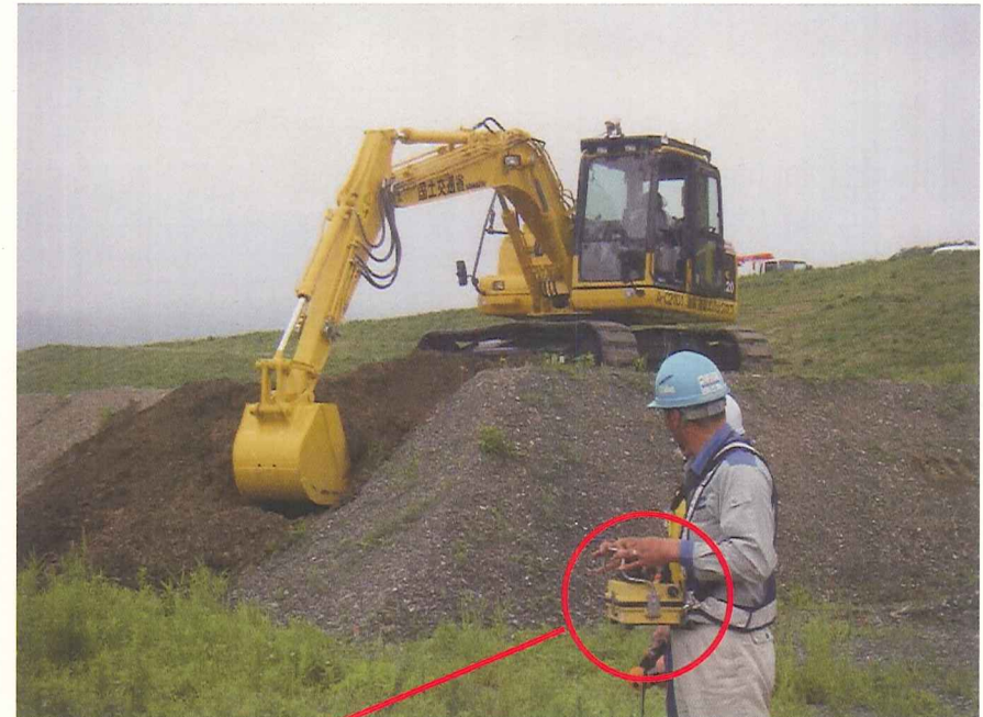
写真-2 遠隔操縦式油圧ショベル(0.5m³)全景
