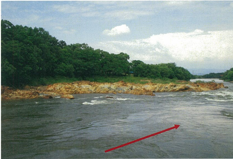
8. 4k付近左岸側の状況
