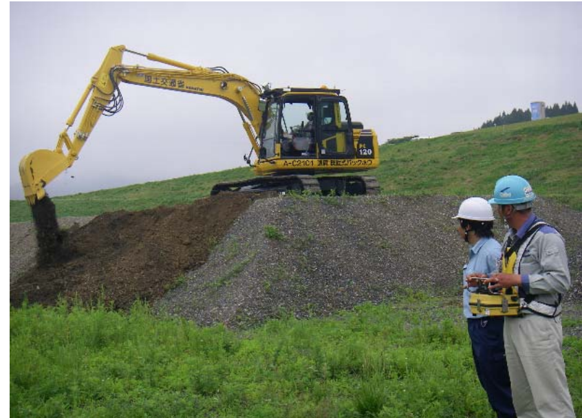
写真-2 遠隔操作による作業状況
