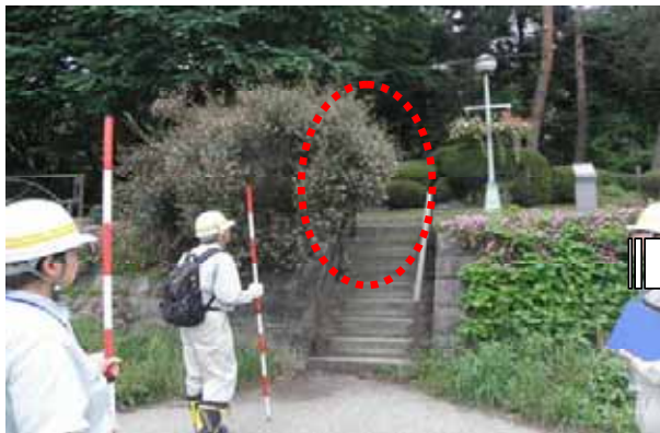
河川公園（中津川中の橋付近） 護岸階段に植栽が張り出している →7月14日に撤去済み
