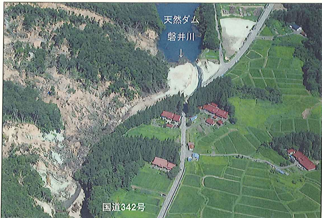
本復旧着手前(平成20年8月撮影)
