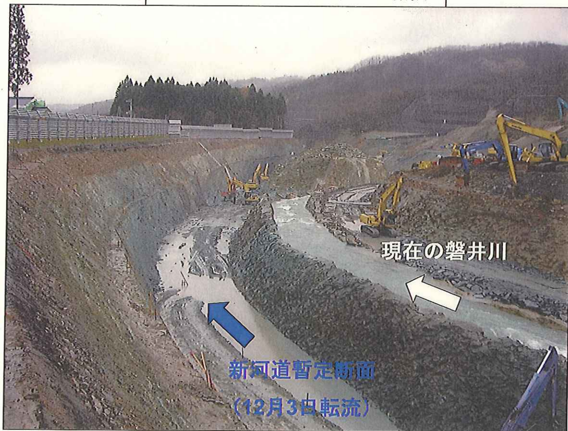
現在の状況(平成21年11月17日撮影)
