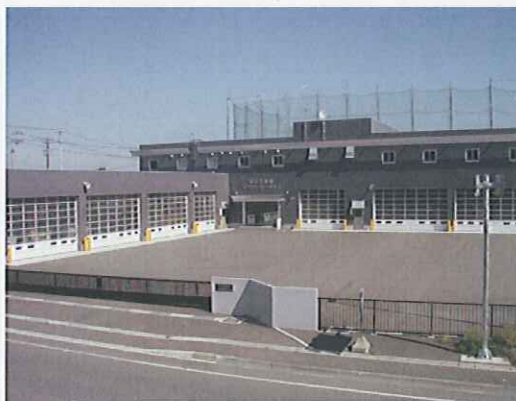
八戸防災ステーション全景
