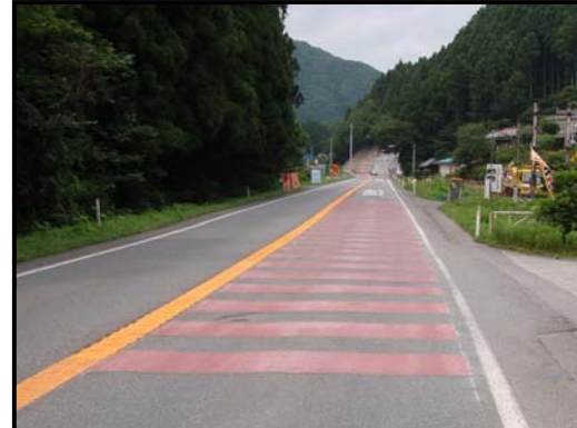
I. ④路面標示 「速度落とせ」 6月26日施工済
