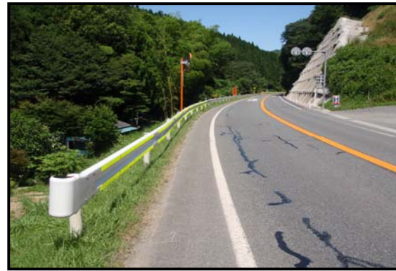
II. ①高輝度反射テープ L=100m(二段) 上・下段:7月15日施工済
