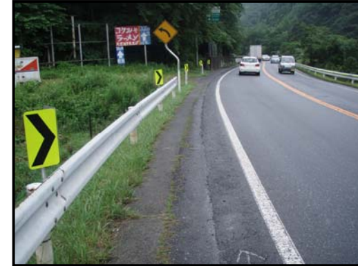
II. ②高輝度反射テープ L=160m(二段) 上段:6月26日施工済 下段:7月15日施工済
