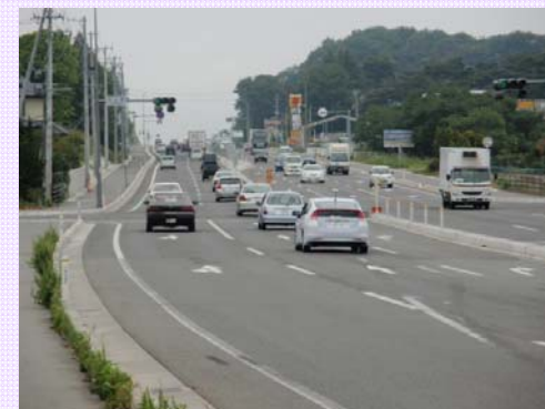
4車線化によりスムーズに
