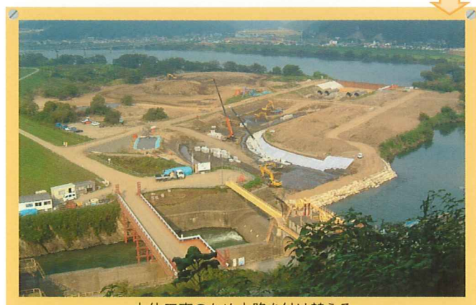
本体工事のため水路を付け替える
