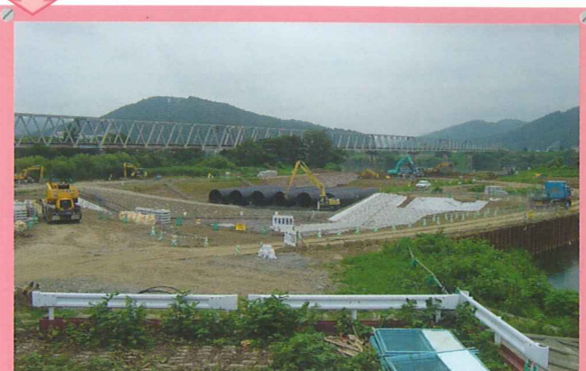
本体工事のため水路を付け替える
