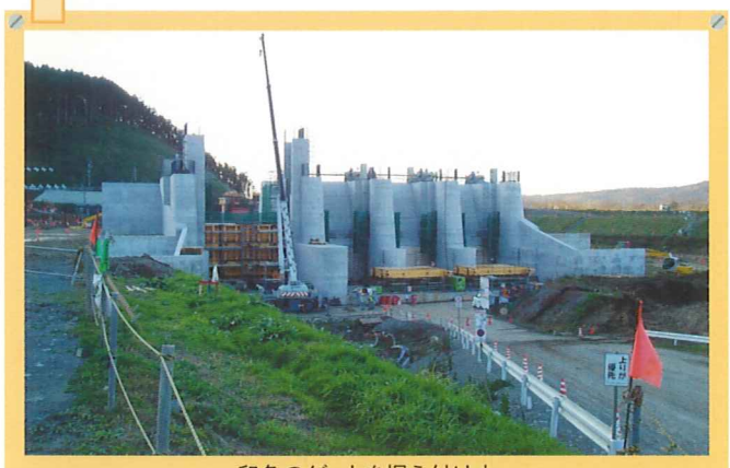
卵色のゲートを据え付け中
