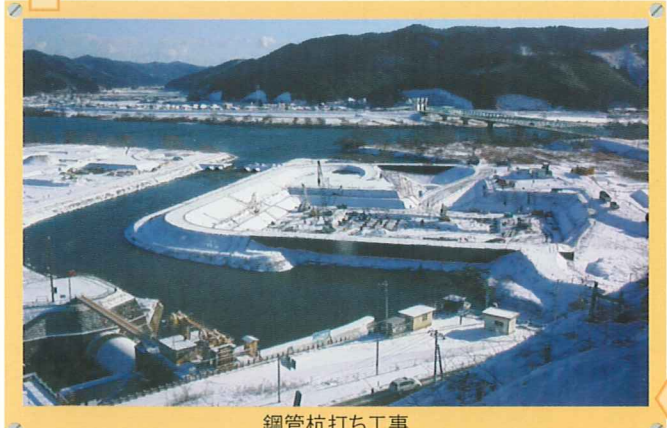
鋼管杭打ち工事
