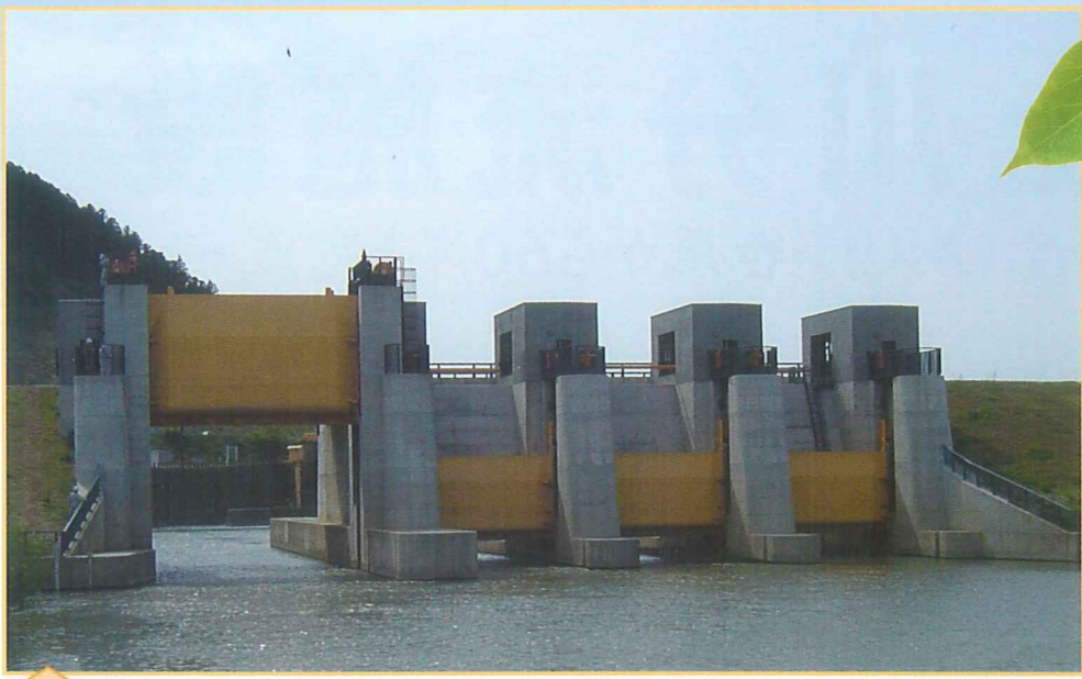
■脇谷水門完成■
