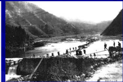
肘折ダム建設工事の様子
