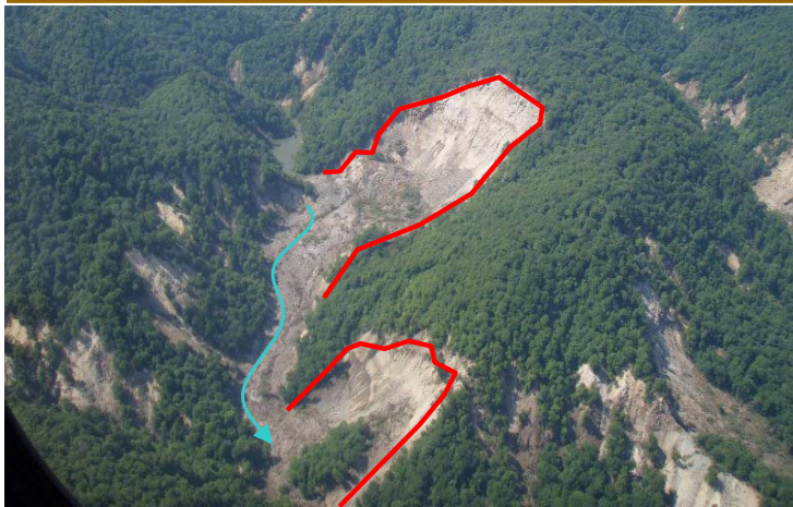
地震直後の崩壊状況
