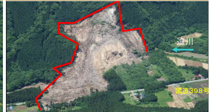
H21. 5. 15撮影(H20. 6. 27 仮排水路通水)
