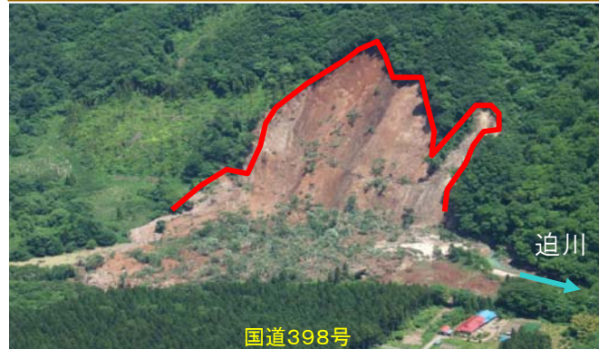
H21. 5. 15撮影(H20. 6. 25 仮排水路通水)
