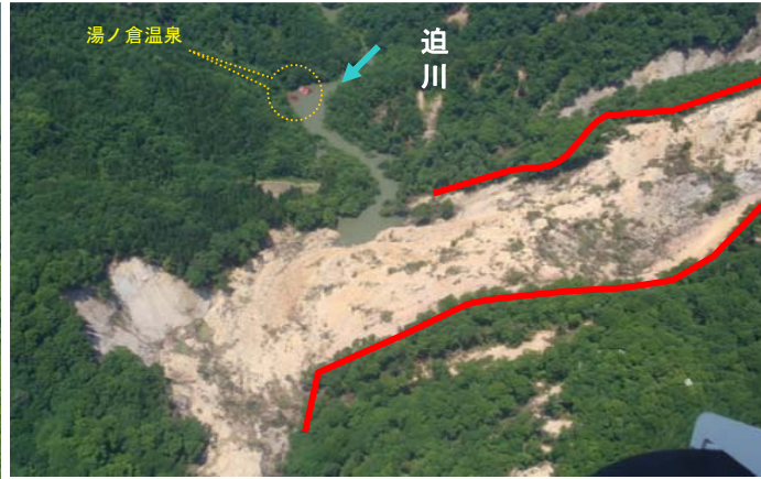
越流侵食状況 (H20. 10. 25撮影)
