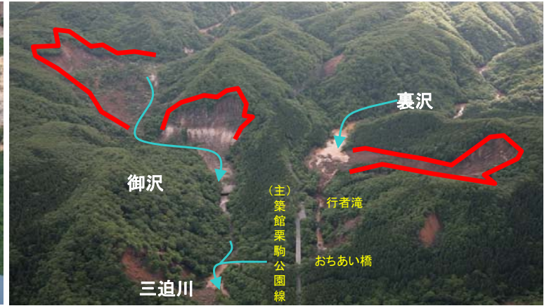
地震直後の崩壊状況
