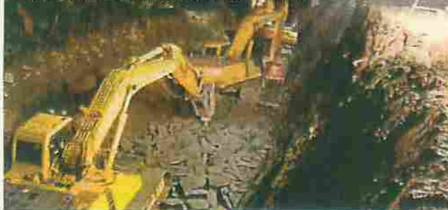
■仮排水の拡幅（通水開始）
