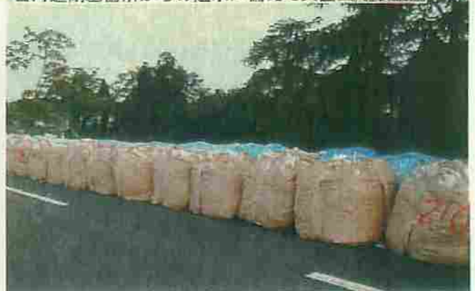
■河道閉塞箇所からの越水に備えて大型土のう設置
