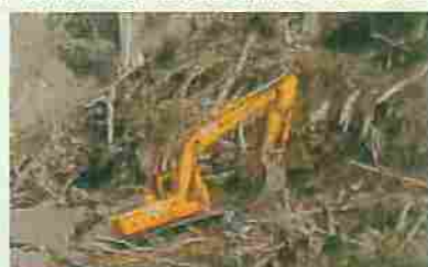
岩手・宮城内陸地震における遠隔操縦式バックホウ作業状況
