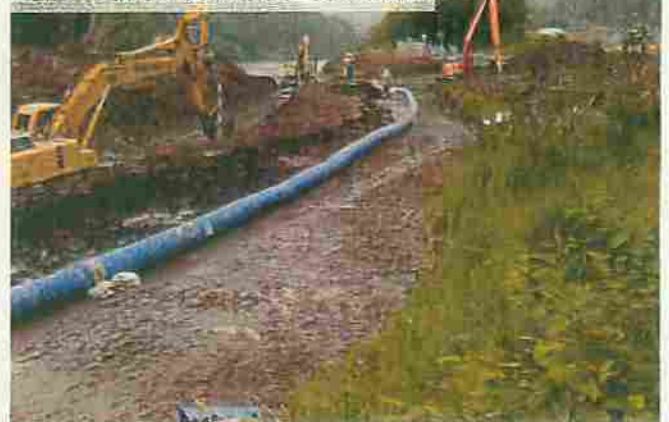
■ポンプ排水による水位上昇の抑制
