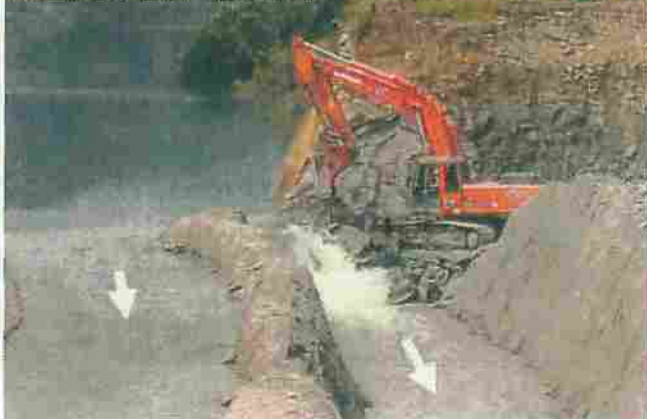
■仮排水の拡幅（通水開始）
