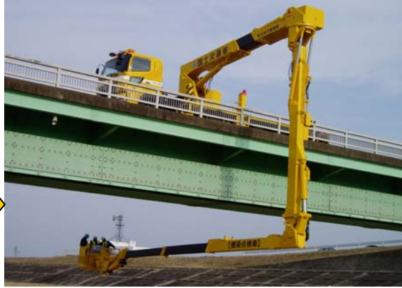
▲実際の橋梁点検の様子
