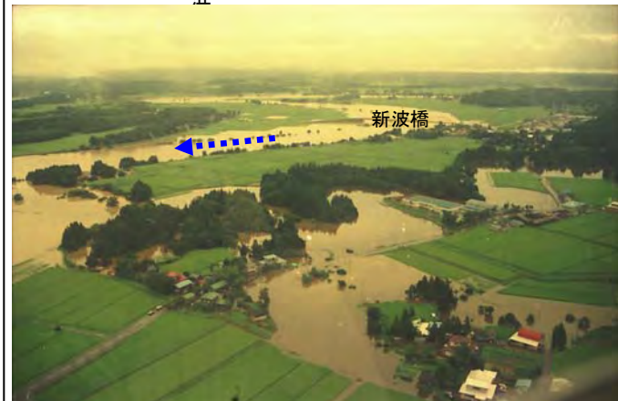
▲S62. 8洪水新波地区浸水状況
