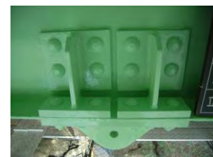
落橋防止装置設置イメージ
