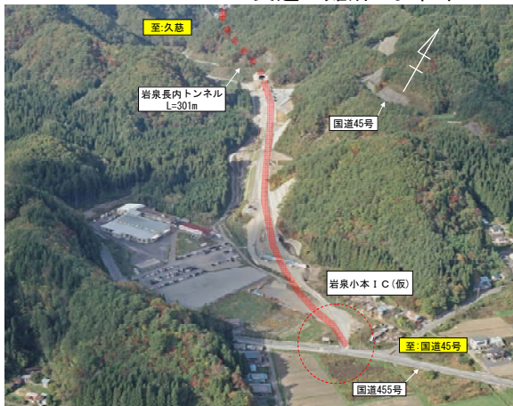
▲起点部(岩泉町大字小本)から久慈側を望む
