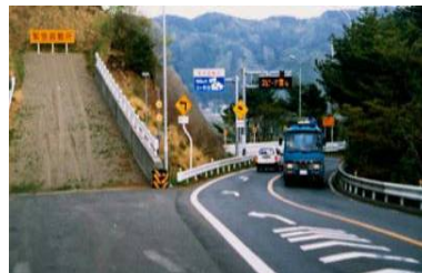
▲並行する国道45号最急縦断勾配10%
