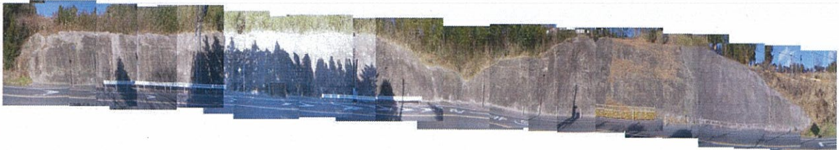
▲北好間地区の法面全景
