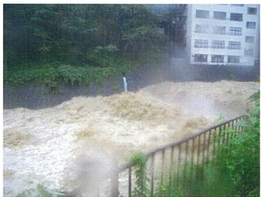
平成18年(2006)10月出水時の状況
