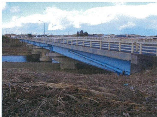
▲真野川橋の全景
