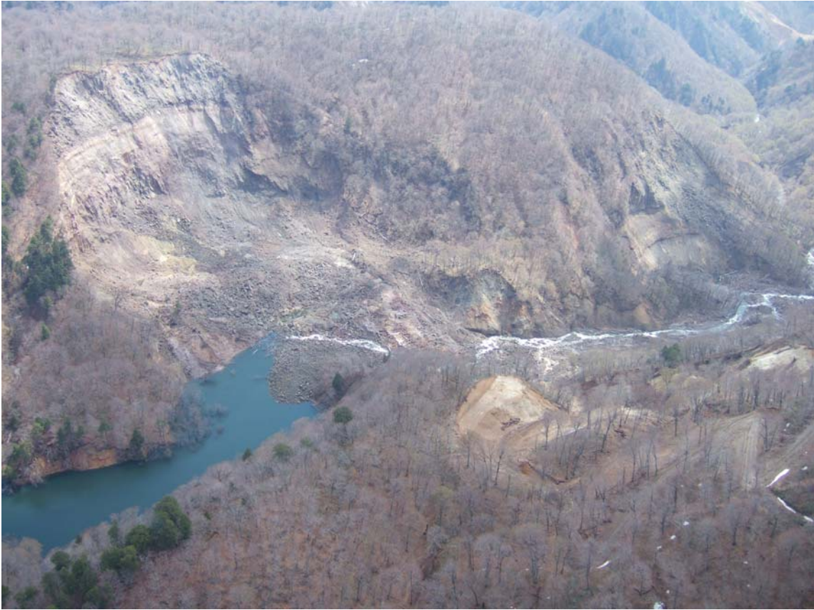
河道閉塞（天然ダム）の全景（おもに下流側）
