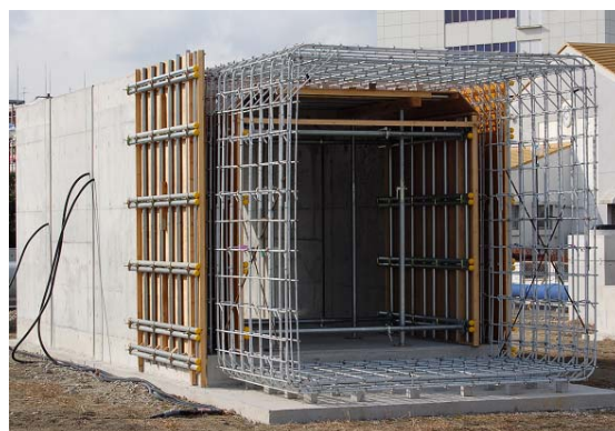
【 函渠工による施工手順の再現 】
