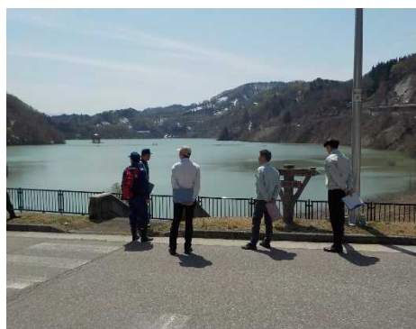
白川ダムの点検実施状況 (ダム堤体周辺)
