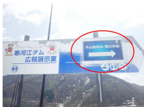
仮補修後(仮の表示シートを設置)
