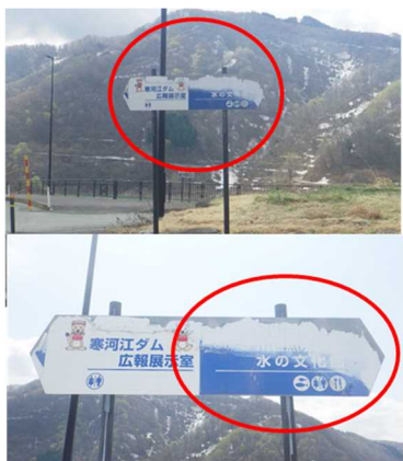
補修前 (案内看板の不具合)
