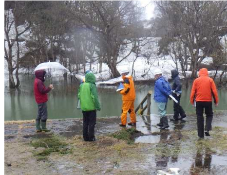
白川ダムの点検実施状況（湖岸公園）
