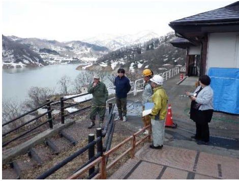
寒河江ダムの点検実施状況（管理庁舎周辺）
