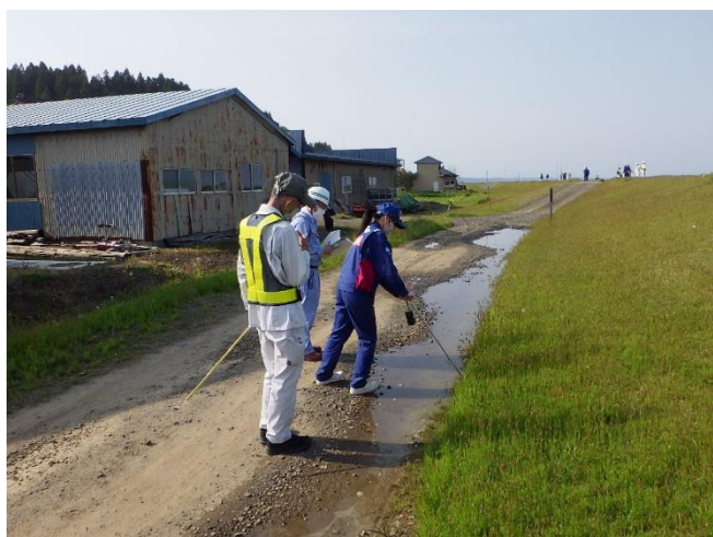
堤防の点検状況
