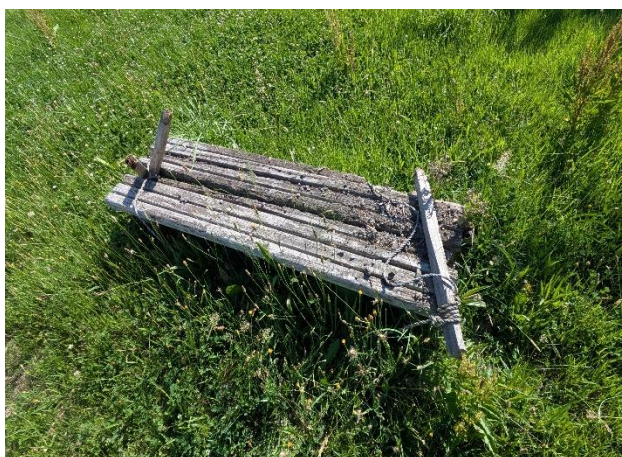
(岩木川河川公園)ベンチの破損
