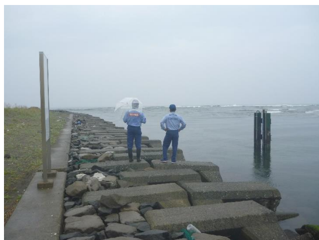
点検状況(高瀬川河口)
