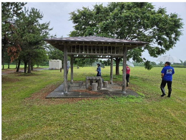
点検状況(稲垣河川公園)
