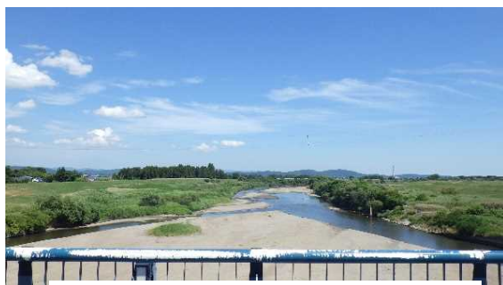
鳴瀬川水系鳴瀬川(R7.7.24撮影)
