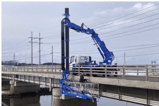
◀ 橋梁点検イメージ
