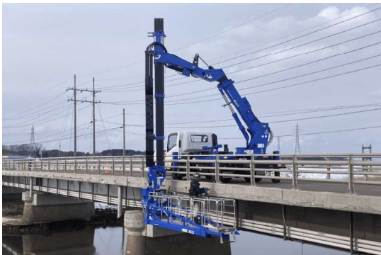
◀ 橋梁点検イメージ
