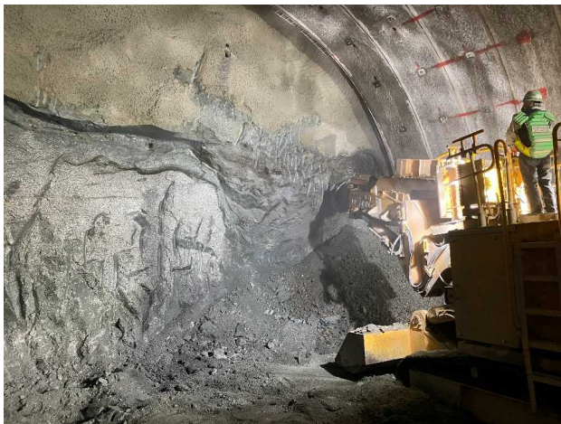
▼トンネル掘削 (機械掘削)
