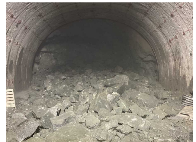
▼発破による巨礫破碎
