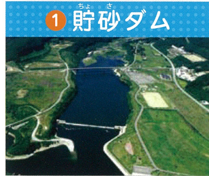
1 貯砂ダム ダム湖に土砂が入ってこないように、ここにためます。
