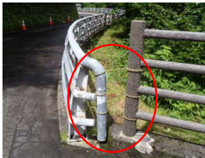
上流側応急処置状況
