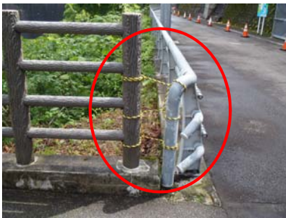
下流側応急処置状況
